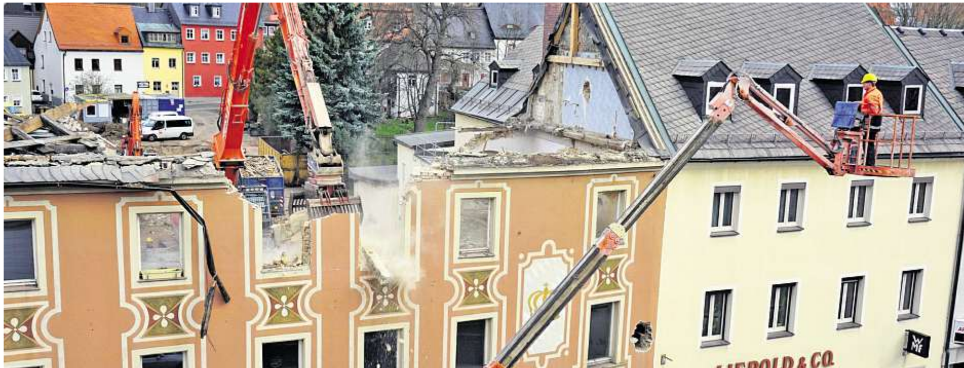
Der Abriss des einstigen Prachthotels „Kronprinz“ geht dem Ende entgegen. Am Donnerstag ging es auch der prunkvollen Fassade zur Maximilianstraße an den Kragen. Foto: Matthias Bäumler Lokalteil
