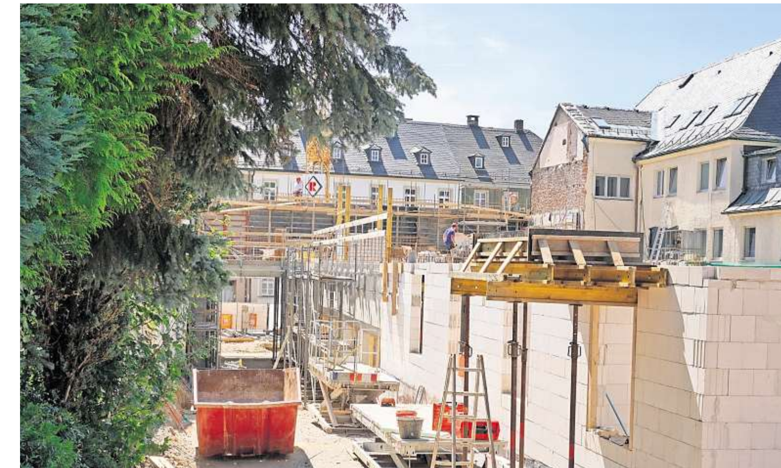
Von der Nordseite aus ist deutlich zu sehen, wie das Geschäfts- und Wohnhaus in die Höhe wächst.
