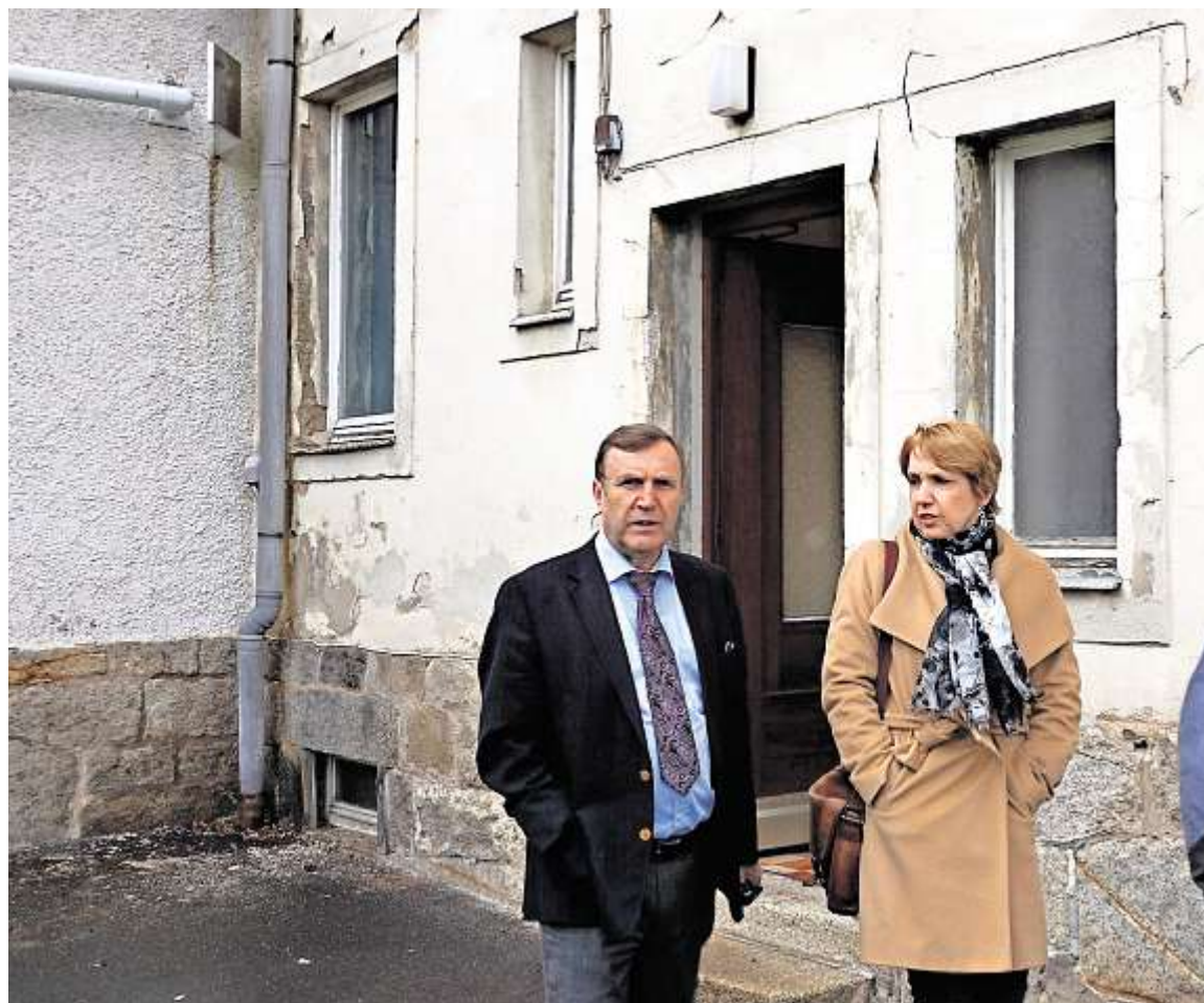
Abblätternde Fassaden und nicht vermietbare Wohnungen haben die Mitglieder der Enquete-Kommission im Landkreis Wunsiedel ebenso gesehen wie modernisierte Bauten, für die Bewerber Schlange stehen. Foto: Bäumler
