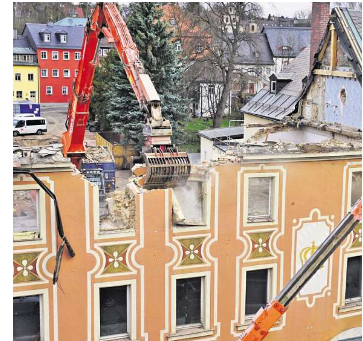
Quadratmeter für Quadratmeter knabbert der Riesenbagger an der Fassade.
