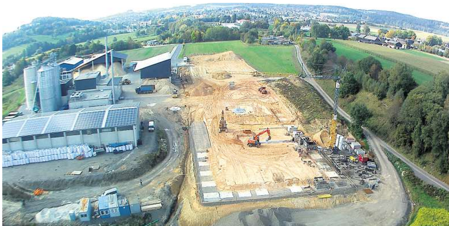
Der Wunsiedler Energiepark wächst: Während in den Hallen links schon einige Jahre Strom aus Biomasse erzeugt wird, entsteht rechts das neue Gaskraftwerk.
