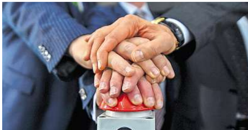
Knopfdruck mit vereinten Kräften: Gemeinsam setzen die Technologiepartner das 8,4-Megawatt-Energiespeichersystem Siestorage in Gang. Foto: Florian Miedl
