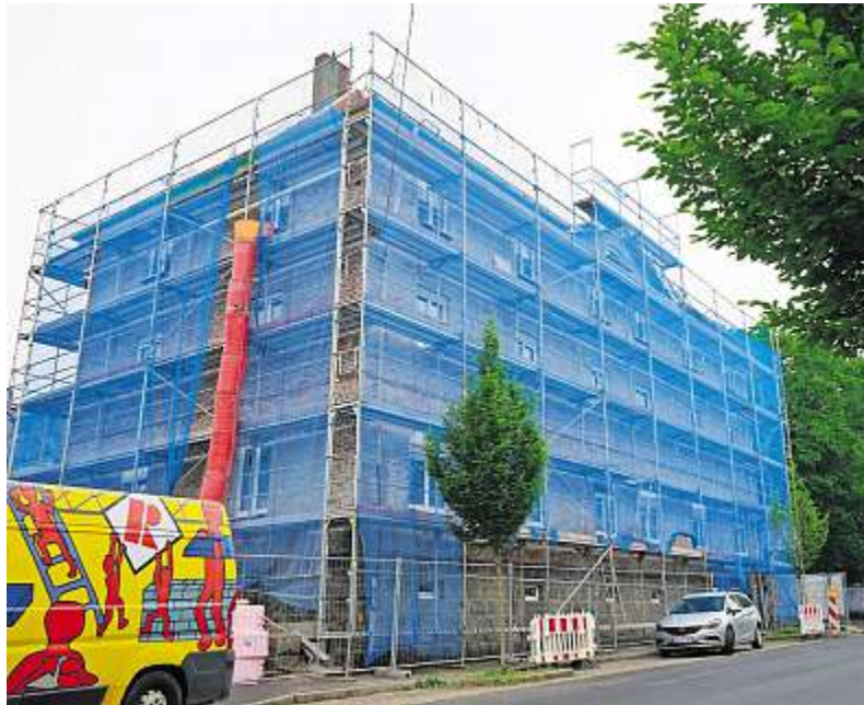
Bis Ende August dauert die Generalsanierung des Hauses. Foto: Matthias Bäumler
